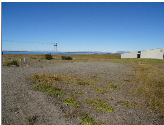
Mynd 5.3.2. Aðstöðuhús Orkuveitu Reykjavíkur við Hafnarveg.
