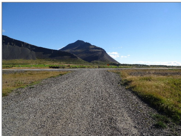
Mynd 5.3.1. Horft eftir Hafnarvegi til austurs í átt að Hringvegi.
