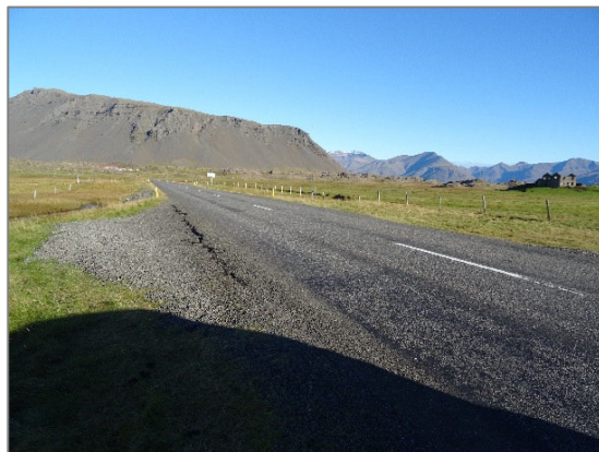
Mynd 12.2.46. Vegkantar svo útflettir að tvisvar sinnum, sumarið 2016, voru malarhlöss sett í kantinn til að sporna gegn því að hann brotnaði niður.
