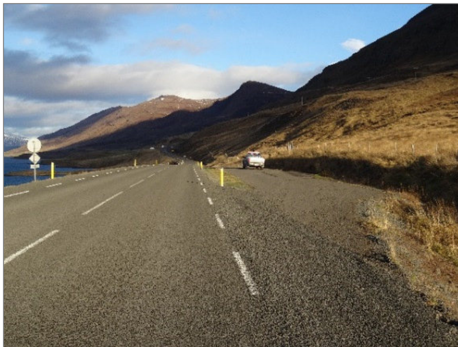
Mynd 8.3.3. Vigtunar- og keðjunarplan í Víkurskarði að vestan. Horft upp á Víkurskarð.
