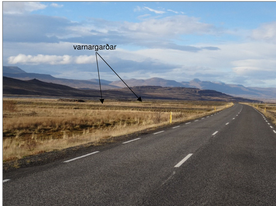
Mynd 7.3.1. Horft til norðurs út yfir varnargarða Héraðsvatna.
