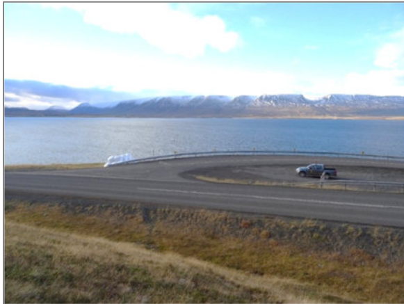
Mynd 8.2.10. Vegamót Grenivíkurvegur og Hringvegur
