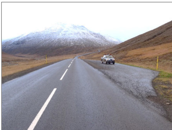
Mynd 8.3.1. Útskot neðan Bakkaselsbrekku.
