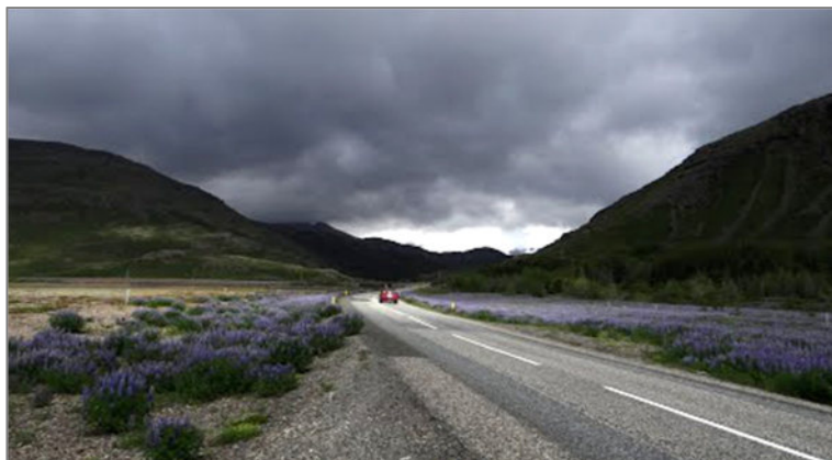
Mynd 12.2.27. Sunnan brúar á Karlsá (ljósmynd: www.googleearth.com )
